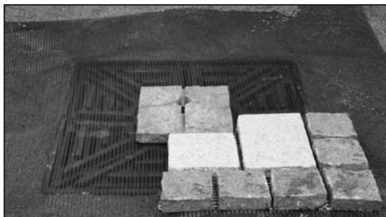
13. Pour la Mosaic Bubble Fountain (58070), continuez en plaçant les (4) sections de pierre extérieures autour de la pierre centrale.
